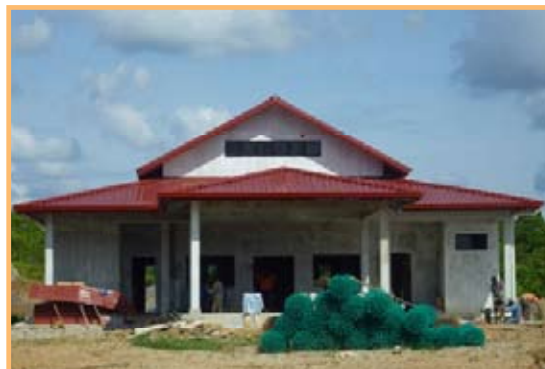
Kerja-kerja menyiapkan bangunan satu tingkat Mahkamah Litar Kinabatangan, Sabah
