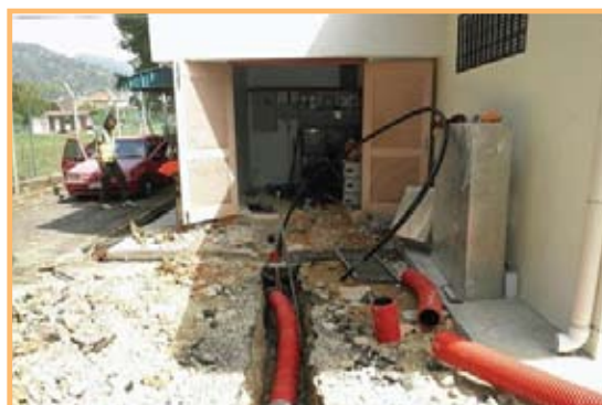
Kerja-kerja menaiktaraf kabel TNB di Mahkamah Sesyen/ Majistret Batu Pahat, Johor
