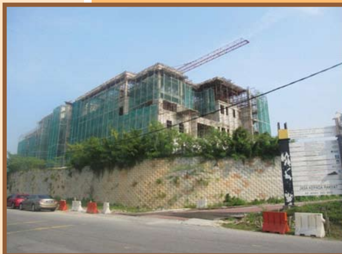
Bangunan Tambahan Mahkamah Baru Klang, Selangor [ 8 Bilik Bicara]
